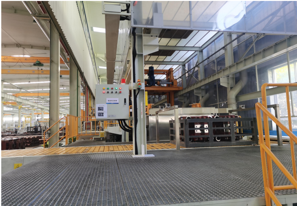
图 5.1-1 改造后的磷化线
